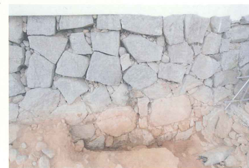
9面調査区 天守台東面石垣
