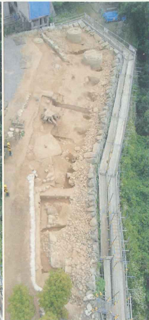
1面調査区石垣解体の様子（北から）※左から3段目、6段目、14段目石材解体状況
