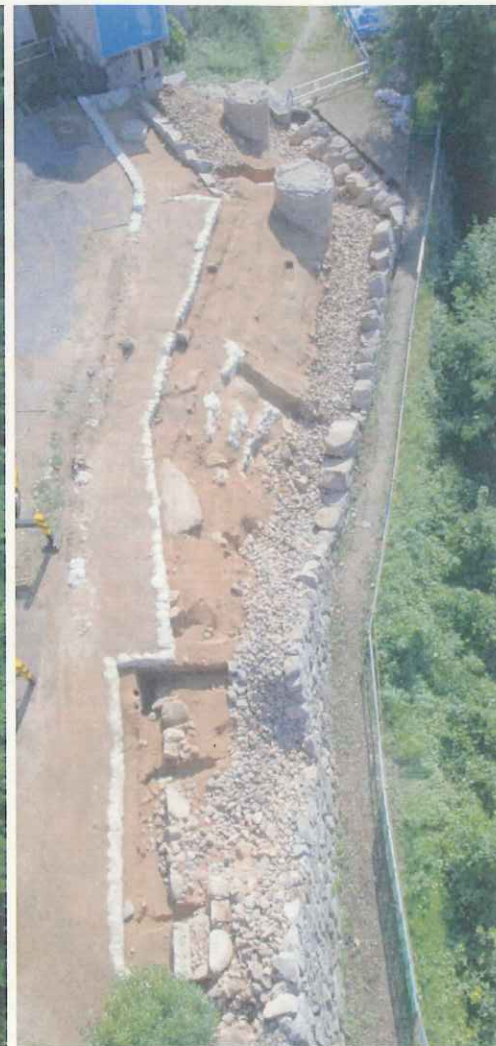
1面調査区石垣解体の様子（北から）※左から3段目、6段目、14段目石材解体状況
