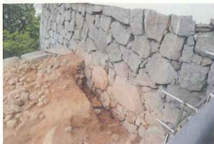
天守台石垣(北東から)
