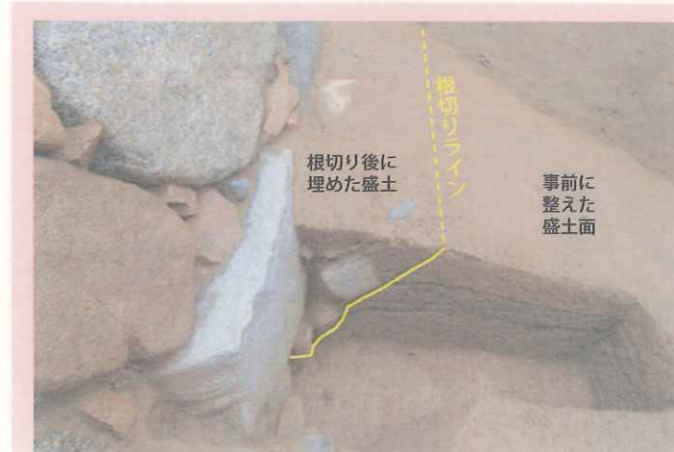
旧石垣の控え出し根石と根切りの様子（南から）
