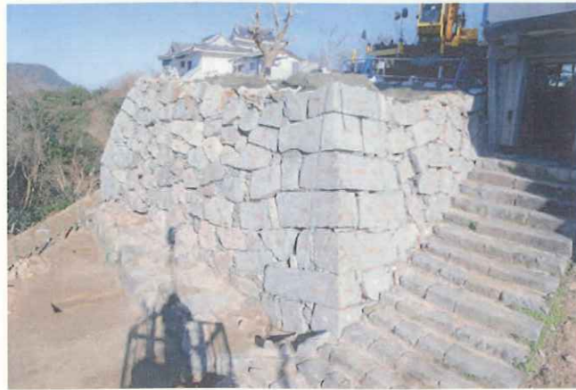
解体前の1～3面石垣（南西から）
