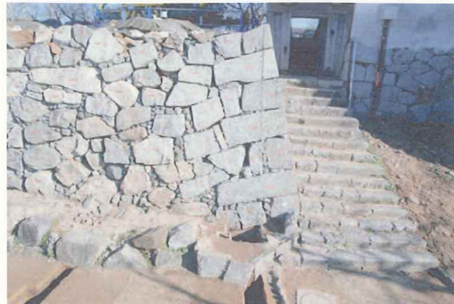
解体前の1～3面石垣（西から）
