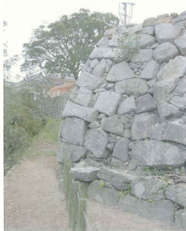
解体前の1～3面石垣（南西から）
