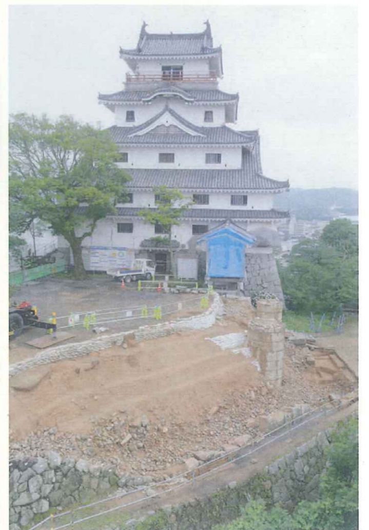
石垣解体完了時（北から）
