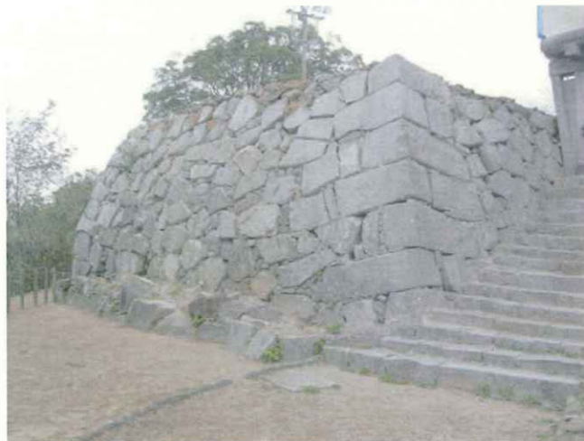
解体前の1～3面石垣（南西から）
