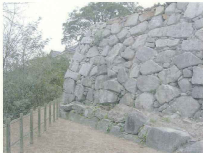
解体前の1～3面石垣（南西から）
