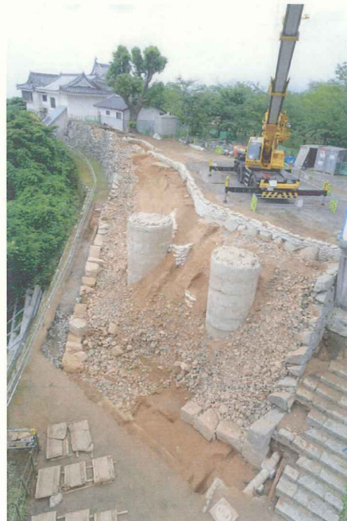
石垣解体完了時（南西から）
