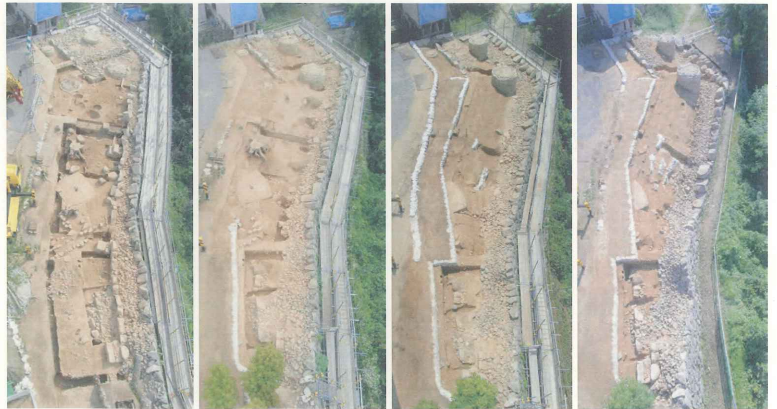
解体中の1～3面石垣（北から）【写真は左から、3段目・6段目・8段目・14段目の解体時：根石付近までの段数は全18段】
