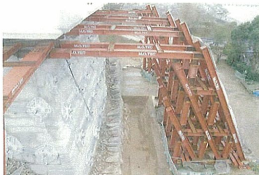
解体した天守台石垣と仮設トラス(西から) 写真中央は天守台南面石垣(7面石垣)。露出した天守閣建物の基礎杭に仮設トラスをあてがっている。石垣の裏には受圧板が並ぶ。
