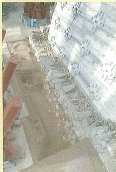
解体された天守台石垣と天守台下旧石垣(南東から)
