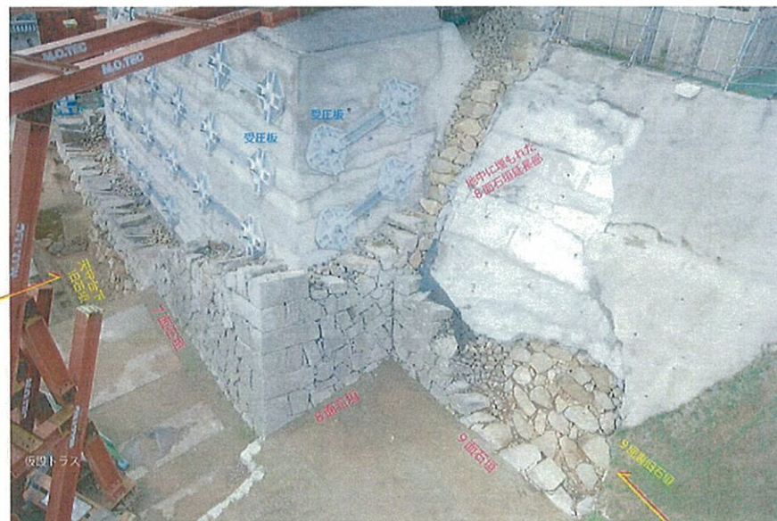
天守台石垣(6～8面石垣)および9面石垣解体状況(南西から)
