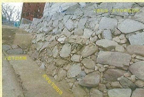
7面下旧石垣と天守台下旧石垣(東から)
