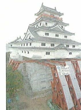
解体した天守台石垣と天守閣建物(南西から)
