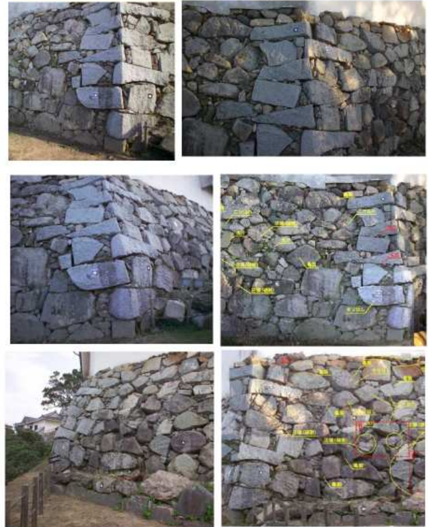
図A 平成17年 唐津城 (1-3,2,3面)の状況
